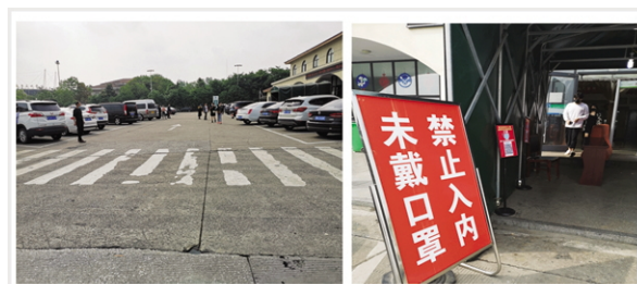
服务区地面破损、标线模糊 防疫岗位无人在岗
